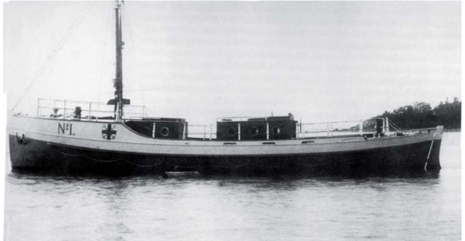
1913 erhielt die finnische Rettungsgesellschaft ihr erstes motorgetriebenes Seenotrettungsboot, ein halbgedecktes Fahrzeug mit Aufbauten und einer Hilfsbesegelung.
