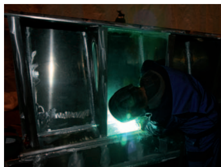
Mariusz Rybecki verschweißte anschließend das Bauteil.
